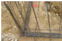
Nœud de chaînage - Continuité mécanique
