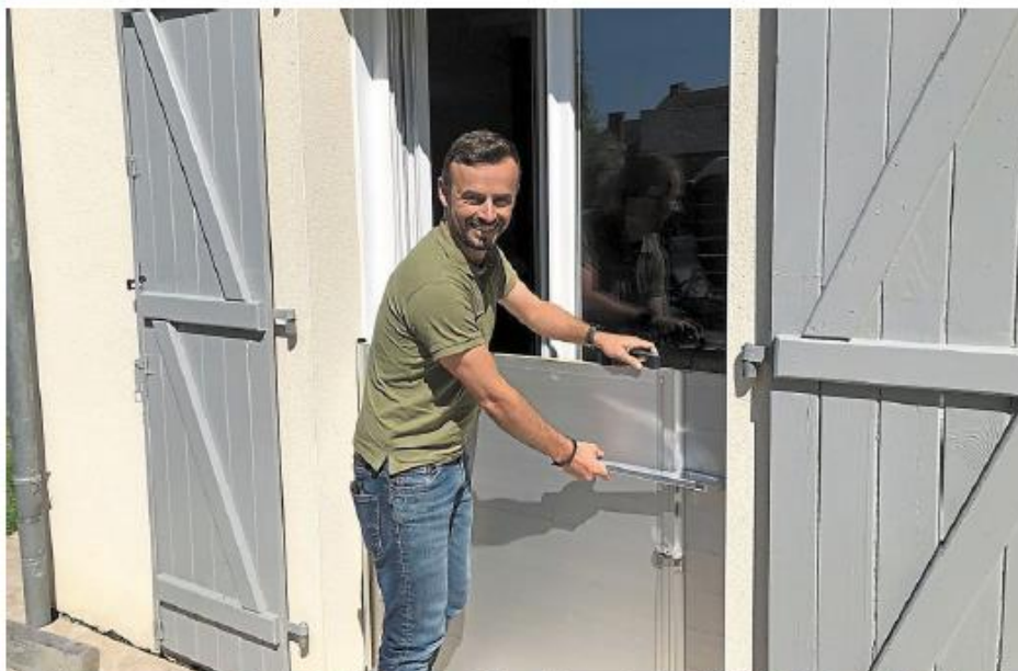
Yves Hamono, propriétaire d'une maison à Guichen-Pont-Réan, est le premier à avoir bénéficié du dispositif Alabri dans le territoire. Il a choisi d'installer des batardeaux, barrières en aluminium anti-inondation.
